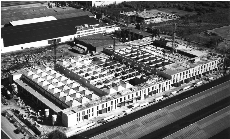
Vista aérea, construcción. Construction site, aerial view.
